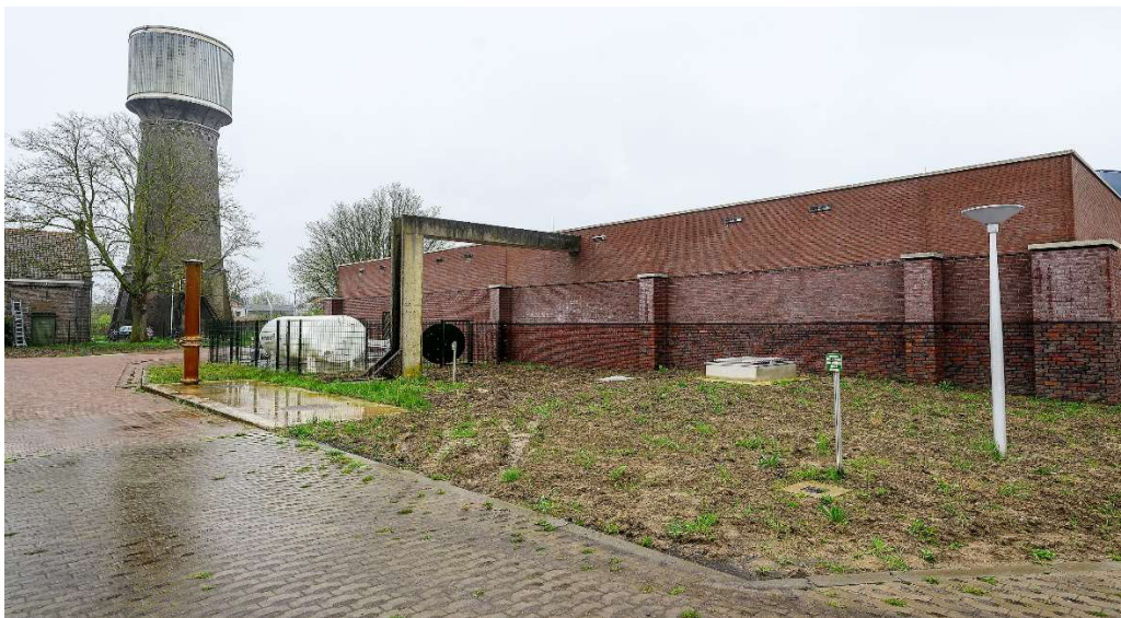
Het gebouw waar de pomp staat voor het warmtenet. Links de oude watertoren die binnenkort wordt verbouwd tot woning. Beeld Guus Dubbelman / de Volkskrant
