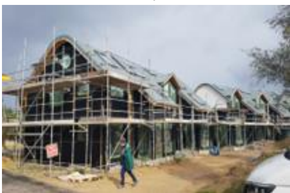
Straatje in aanbouw
