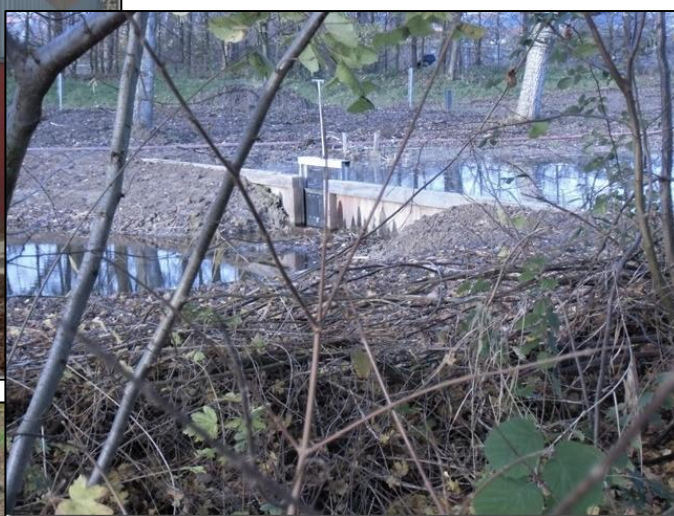
De stuw tussen de twee nieuwe vijvers, let op het niveauverschil
