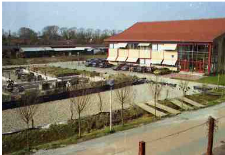
Het in aanbouw zijnde helofytenfilter aan de Frederik van Eedenlaan (voorjaar 2003).
